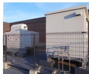
〈非常用発電機〉
